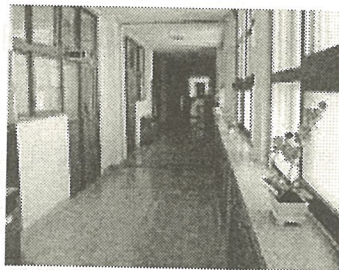
[그림 2] 창문과 출입문 리모델링
